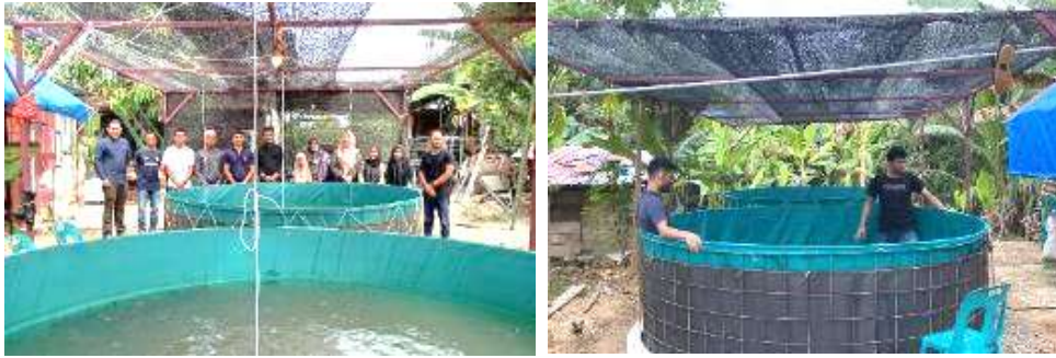
Gambar 3. Tahapan Pembangunan Bioflok di Gampong Mata Ie, Kecamatan Montasik, Kabupaten Aceh Besar
