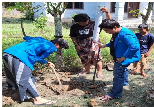
Gambar 6 Proses Penggalian Lubang Resapan Biopori
