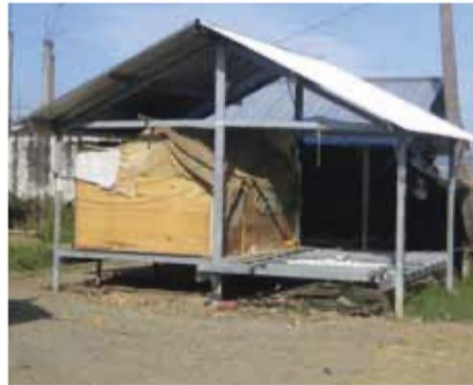
Gambar 2. Kerangka shelter sebelum pemasangan dinding (sumber: Florian Steinberg, 2010)
