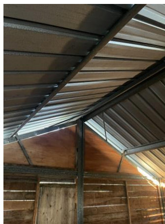
Gambar 6. Atap pada shelter (sumber: dokumen pribadi, 2025)
