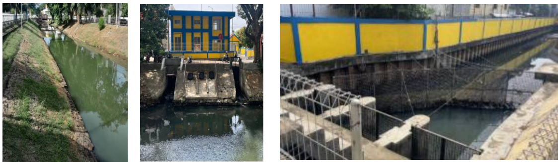
Gambar 2. Sungai Krueng Daroy dan Kolam Retensi Rumah Pompa (sumber: dokumentasi, 2024)
