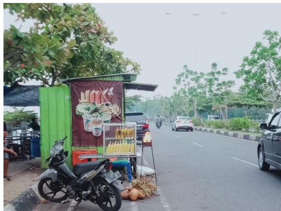
Gambar 1. Kondisi Eksisting Jalan Pelabuhan Ulee Lheue
