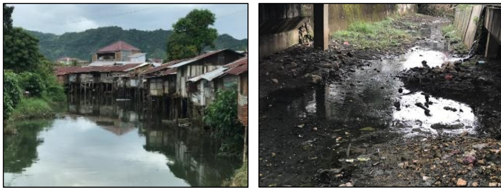
Gambar 7. Foto Kondisi Kawasan Kumuh (Dokumentasi Pribadi, 2022)
