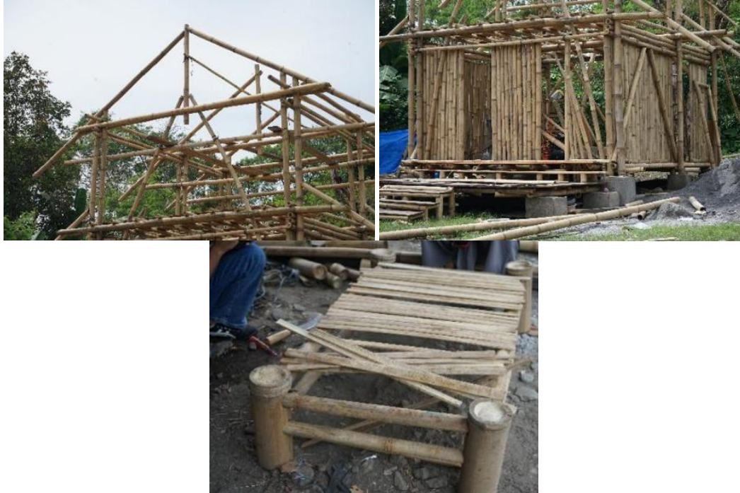
Gambar 6. Atap Bambu Betung sebagai struktur utama, Dinding bambu Regen sebagai elemen arsitektural, Furnitur dari Anak Bambu pada interior
