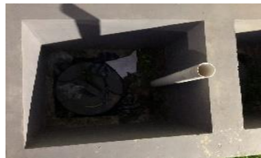
Gambar 5. Instalasi pengelolaan greywater untuk penyiraman tanaman (belum aktif)
