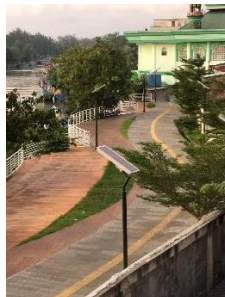
Gambar 3. Sistem sensorik dan solar panel pada lampu taman (sumber: Pribadi, 2025)
