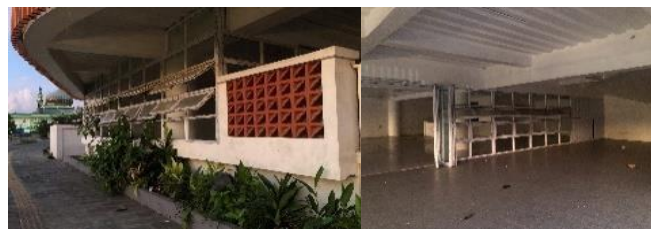
Gambar 2. Sistem penghawaan pasif pada bangunan (sumber: Pribadi, 2025)
