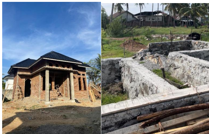
Gambar 1. Perumahan tipe 52 satu lantai dengan pondasi batu kali pada kawasan Lamkенеung, Aceh Besar (sumber: dokumen pribadi, 2023)
