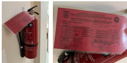
Gambar Bukti Pengujian dan Inspeksi APAR Eksisting
