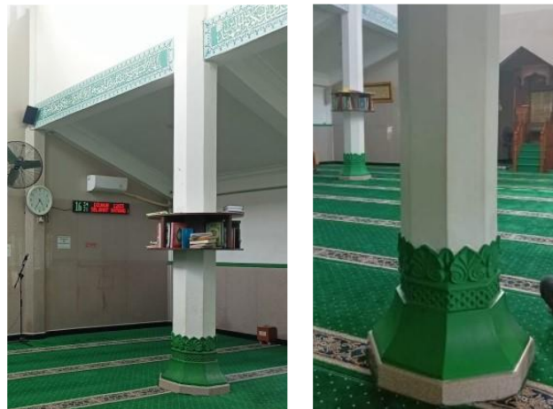
Gambar 7. Elemen Tiang Beton Pada Masjid Teungku di Anjong (dokumentasi pribadi, 2024)
