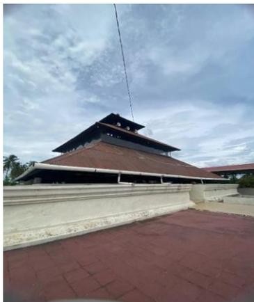
**Gambar 11. Atap berbentuk limas dengan struktur berundak**
