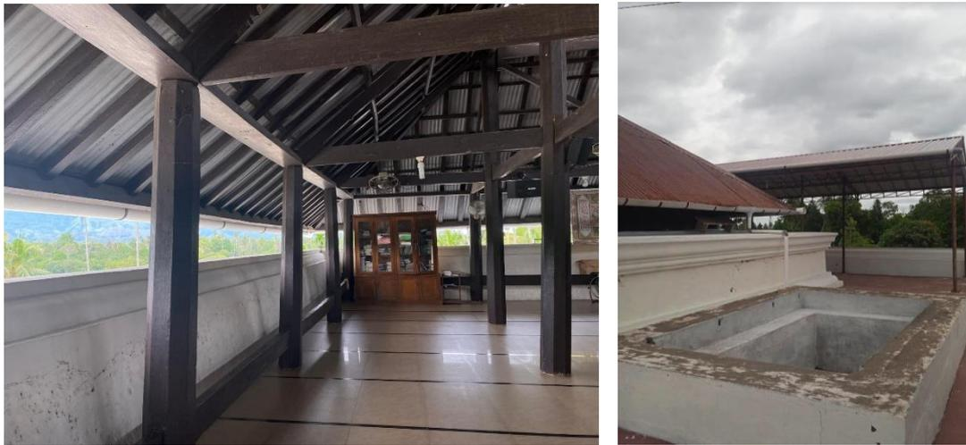
**Gambar 8. Penghubung dan penyangga antar tiang, bak penampungan tempat wudhu**
