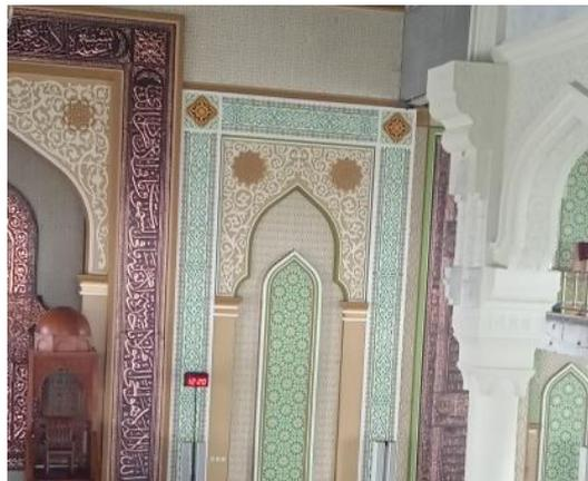
Gambar 5: Dinding di Masjid Baitussalihin terbuat dari bata plester dengan finishing GRC
