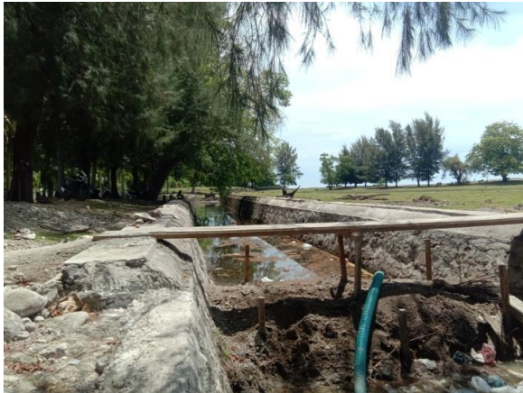
Gambar 5. Kondisi dinding kanal di sebelah selatan hingga utara sedang (Dok. Penulis 7 Juni 2022)
