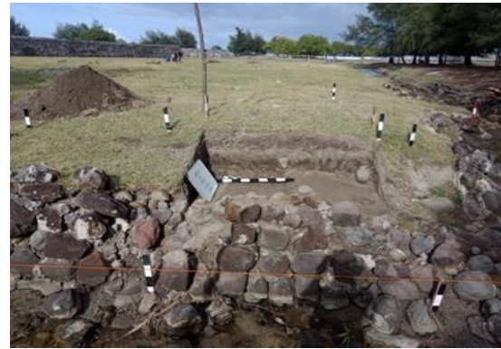
Gambar 2. Kondisi struktur talud kanal arah barat daya (Dok. Penulis 21 Agustus 2021)
