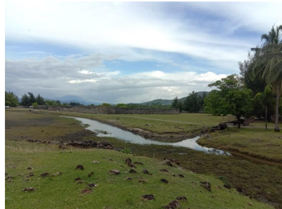
Gambar 3. Kondisi kanal yang telah rusak (Dok. Penulis 7 Juni 2022)
